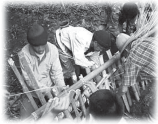
การสร้างฝายชะลอน้ำ ณ ห้วยบง พื้นที่ของดอยผาส้ม
