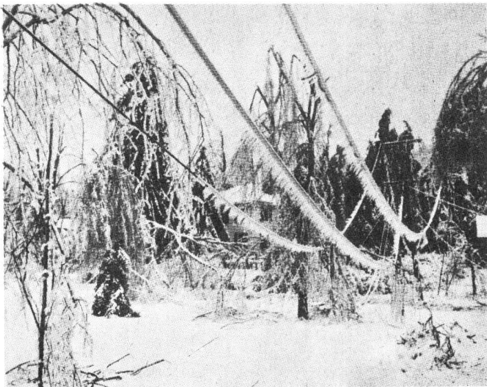
รูปที่ 6.10 ความเสียหายของสายโทรเลขและกิ่งไม้ อันเกิดจากการตกและเกาะของฝนปนหิมะ ทางภาคตะวันออกเฉียงเหนือของรัฐนิวยอร์ก ในเดือนมกราคม ปี 1943
