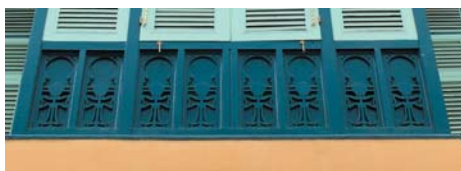
ลายฉลุไม้คล้ายไม้กางเขน ได้บานหน้าต่าง ของมุขด้านทิศตะวันตกเฉียงเหนือ
