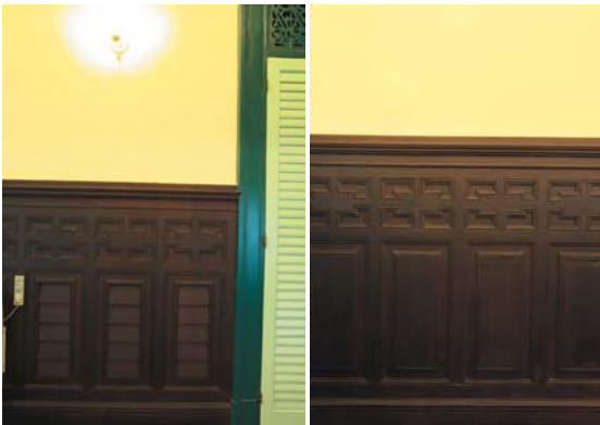
ผนังส่วนล่างแกะสลักเป็นกรอบไม้บานลูกฟัก ส่วนบนสลักลายคล้ายประแจ (Fret)
