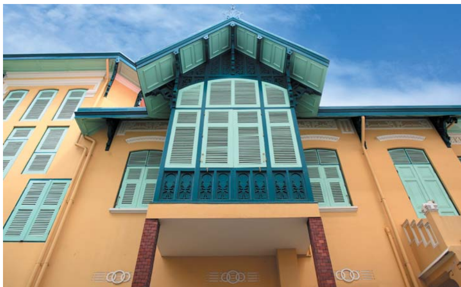
มุขอาคารด้านทิศตะวันตกเฉียงเหนือก่อสร้างด้วยไม้ มีหน้าต่างบานเกร็ด
