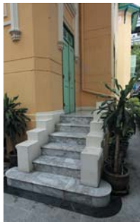
บันไดเล็กๆ อาคารด้าน ทิศตะวันออกเฉียงใต้
