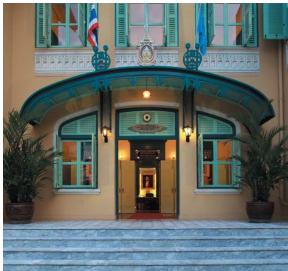
กันสาดโค้งหน้าอาคารประดับลวดลายฉลุ
