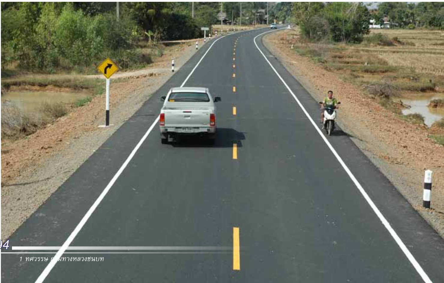
ถนนบ้านหนองน้ำชุ่ม ต.ทะเลน้อย อ.ลำปลายมาศ จ.บุรีรัมย์
