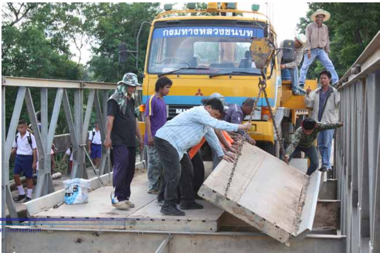
ทชจ.เพชรบูรณ์ ติด ตั้งสะพานเหล็กสาย พช.4011 บรรเทาเหตุ อุทกภัย
