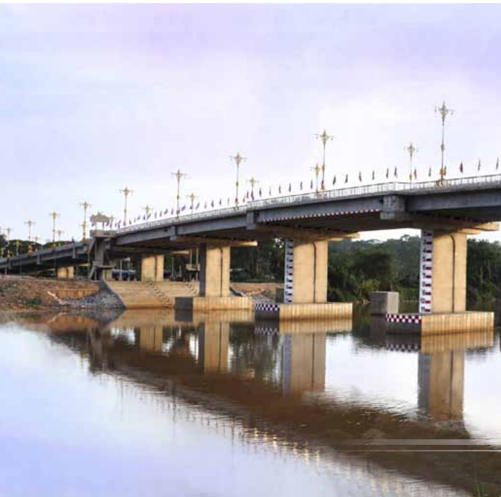
สะพานข้าพญาเมืองราย ข้ามแม่น้ำกก อ.เมือง จ. เชียงราย
