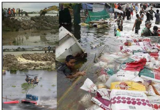
ภาพที่ 2: การทำคันกั้นน้ำบริเวณนคร
