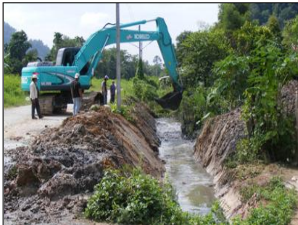
ภาพที่ 30- 31: เทศบาลเมืองทุ่งสง ขยายลำคลองให้มีความกว้างมากขึ้นเพื่อขยายช่องทางระบายน้ำ
