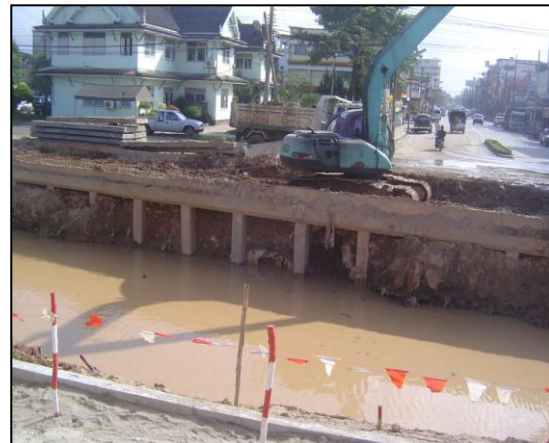
ภาพที่ 30- 31: เทศบาลเมืองทุ่งสง ขยายลำคลองให้มีความกว้างมากขึ้นเพื่อขยายช่องทางระบายน้ำ
