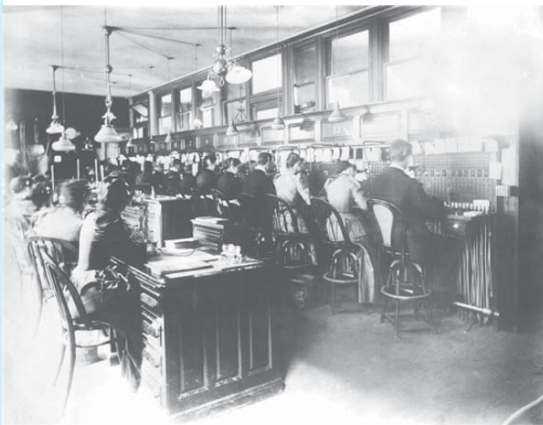
รูปที่ ๑๐ ห้องสะพานไฟฟ้า (Switchboard) สำหรับการสลับสัญญาณ โทรเลขทางไกล ภาพจาก AT&T Archives
