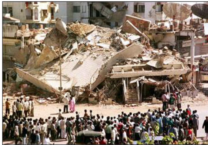
รูปที่ 8 ความเสียหายจากแผ่นดินไหวขนาด 7.9 ริกเตอร์ ประเทศอินเดียเมื่อ มกราคม 2544
